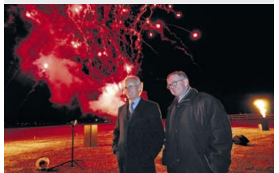
Der Luzerner Regierungsrat Max Pfister und der städtische Baudirektor Kurt Bieder freuen sich am nächtlichen Feuerzauber, der den Baubeginn der Tiefbahn auf der Luzerner Allmend markierte.
